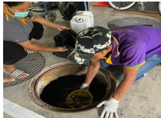
เจ้าหน้าที่ดำเนินการตัดกากไขมันระบบบำบัดน้ำเสีย
