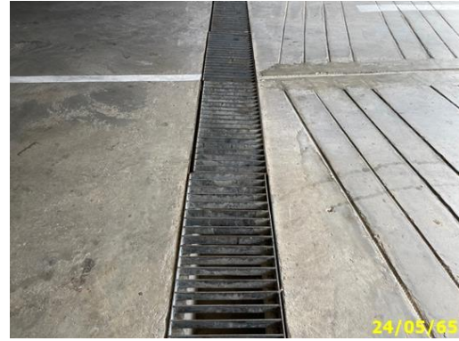
รางระบายน้ำ พร้อมฝาตะแกรงครอบ
