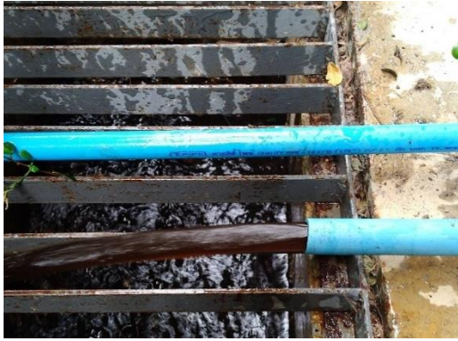
ล้างทำความสะอาดเครื่องกรองน้ำ
