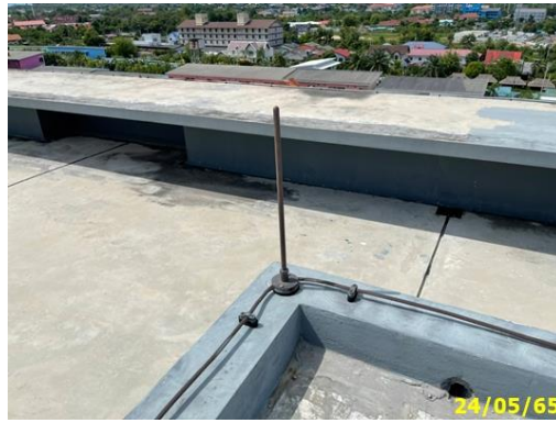
ภาพที่ 2.2-11 การป้องกันอันตรายจากฟ้าผ่า
