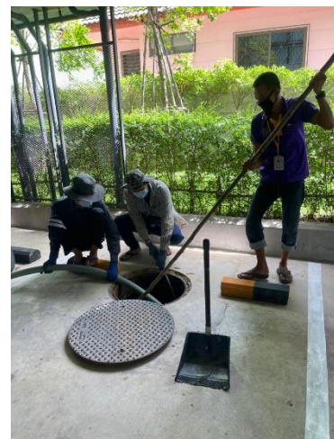
เจ้าหน้าที่ดำเนินการสูบน้ำตะกอนระบบบำบัดน้ำเสีย
