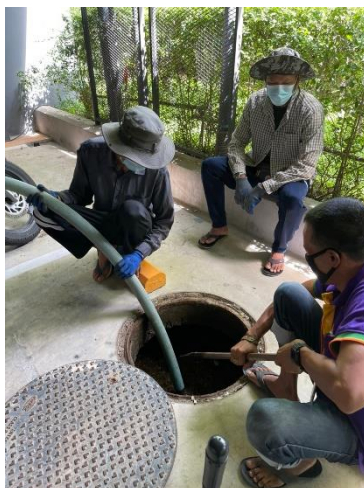
เจ้าหน้าที่ดำเนินการสูบน้ำตะกอนระบบบำบัดน้ำเสีย
