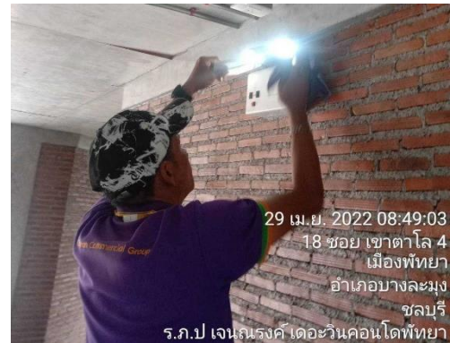
เจ้าหน้าที่ดำเนินการตรวจสอบอุปกรณ์แจ้งเหตุเพลิงไหม้
