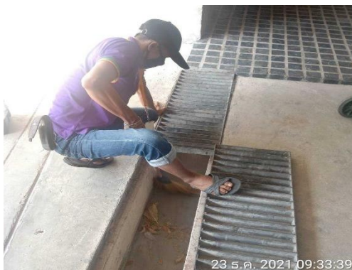
เจ้าหน้าที่ดำเนินการทำความสะอาดรางระบายน้ำ
